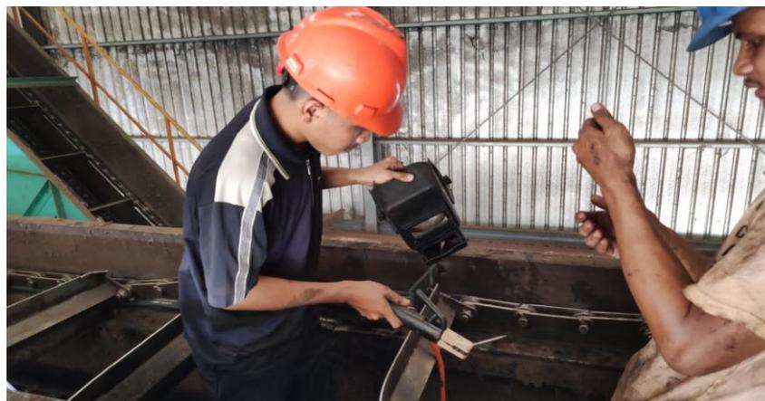
Gambar 4.9 Pemasangan limbah pegas sebagai liner
