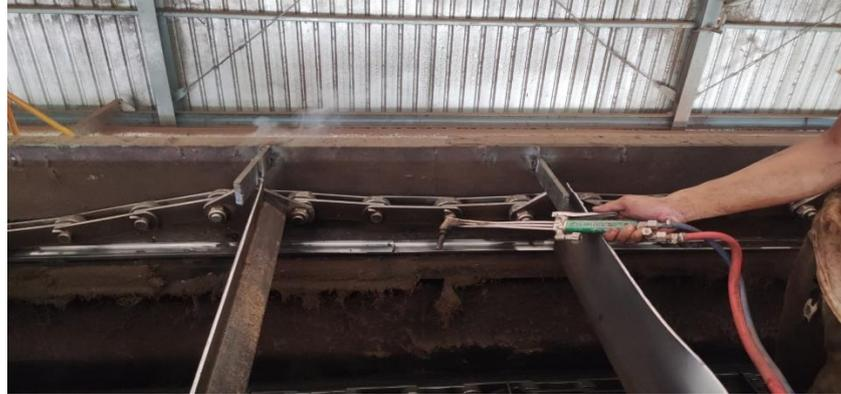
Gambar 4.7 Pencopotan liner rusak menggunakan cutting torch
