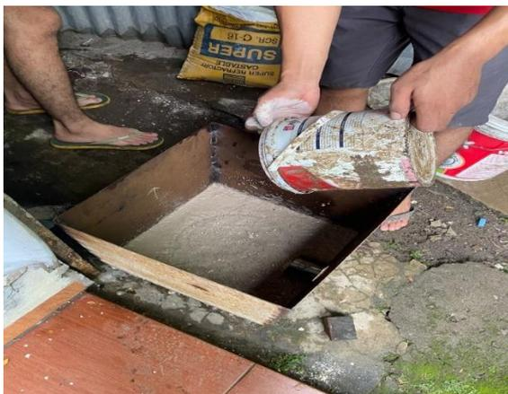
Gambar 4.9 Proses Pengecoran Tungku
