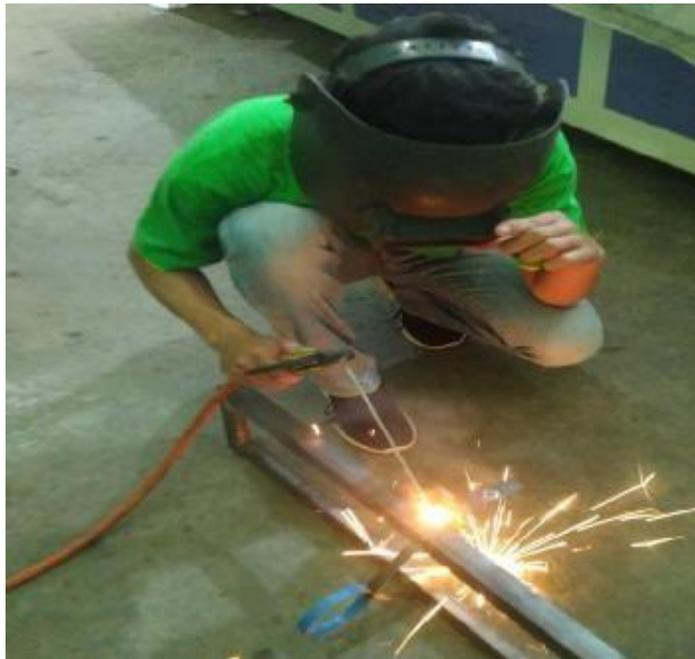
Gambar 4.17 Pengelasan pada dudukan electric fuel pump
