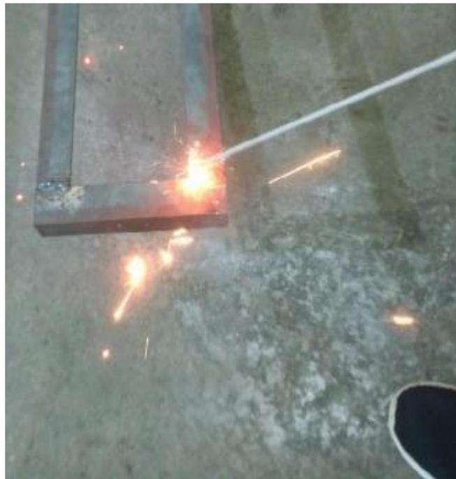
Gambar 4.15 Pengelasan bagian atas
