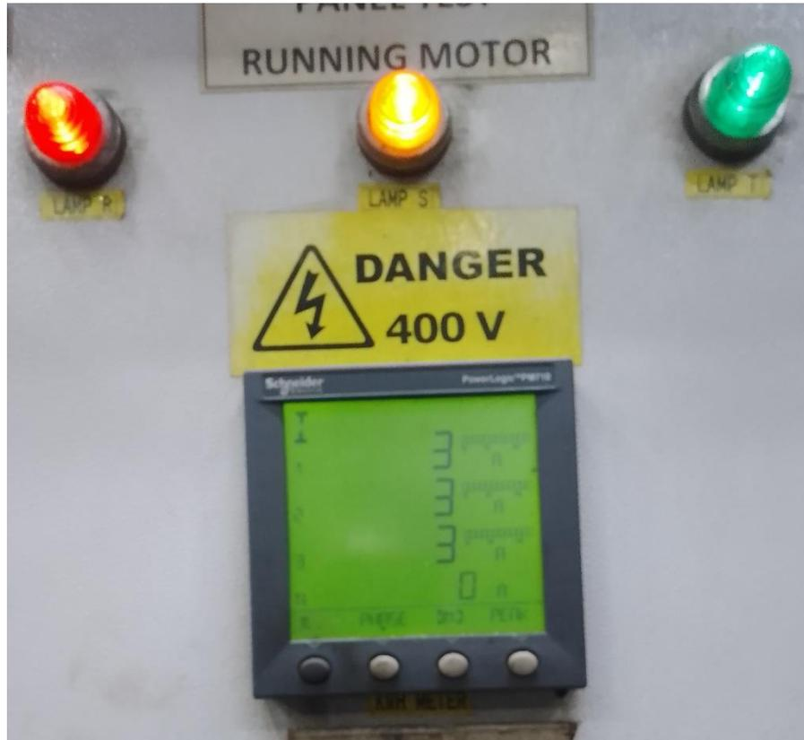
Gambar 4.17 Pengecekan Arus Dengan Tampilan Digital
