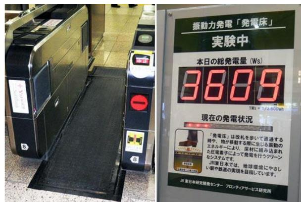
Gambar 2.20 Instalasi Karpet Piezoelektrik di Gerbang Tiket Stasiun Tokyo
