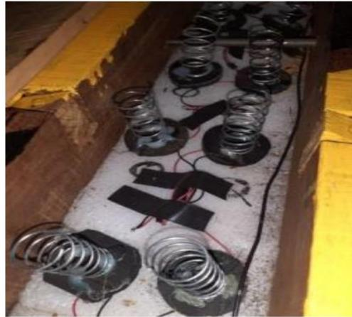
Gambar 2.21 Perakitan Piezoelektrik pada Speed Bumper
