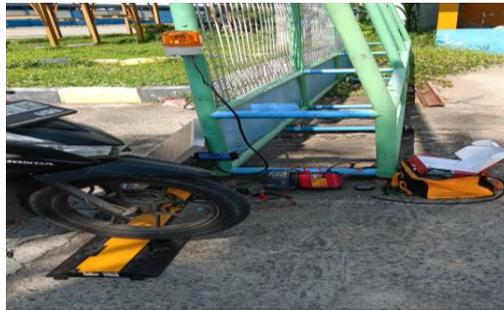
Gambar 4.3 Instalasi Rancang Bangun System Hybrid Solar cell dan Piezoelektrik Pada Polisi Tidur
