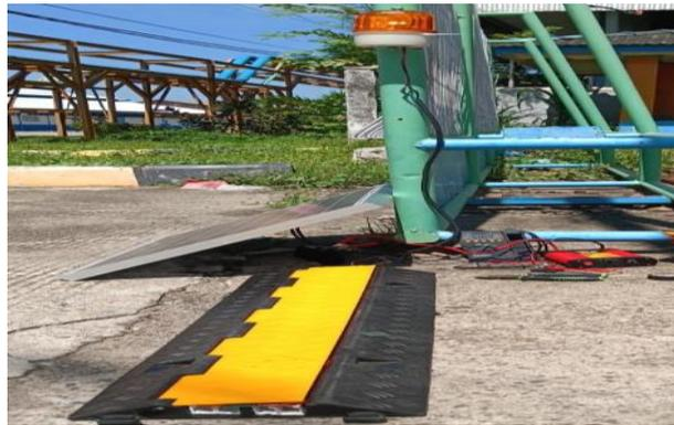
Gambar 4.11 Instalasi Lampu Warning Light Pada Sistem Hybrid Solar Cell dan Piezoelektrik
