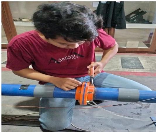
Gambar 4.6 Memasang Baut Pada Sambungan Pipa
