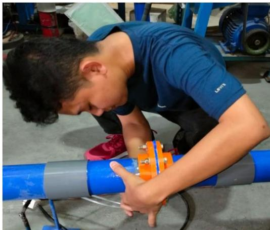
Gambar 4.19 Pemasangan selang *waterpass*
