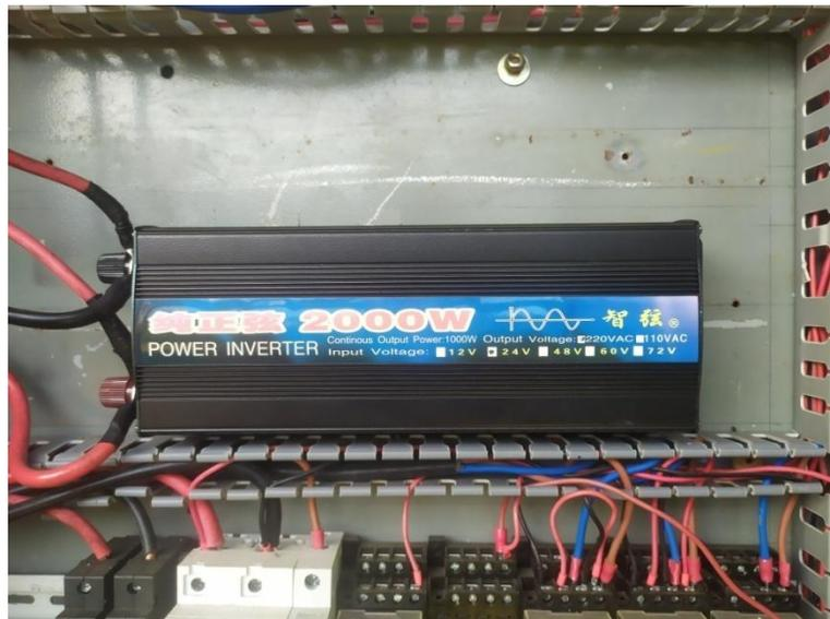
Gambar 3.3. Inverter pada PLTS Bintang Asih
