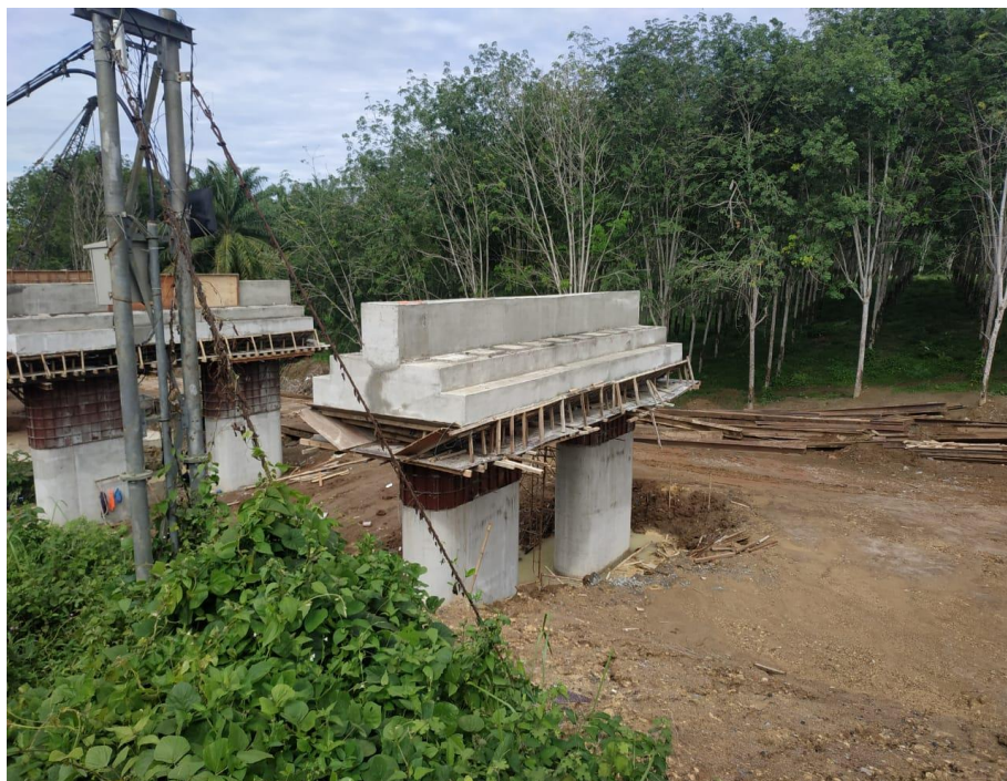
Gambar L4: Pilar Jembatan BH-3
