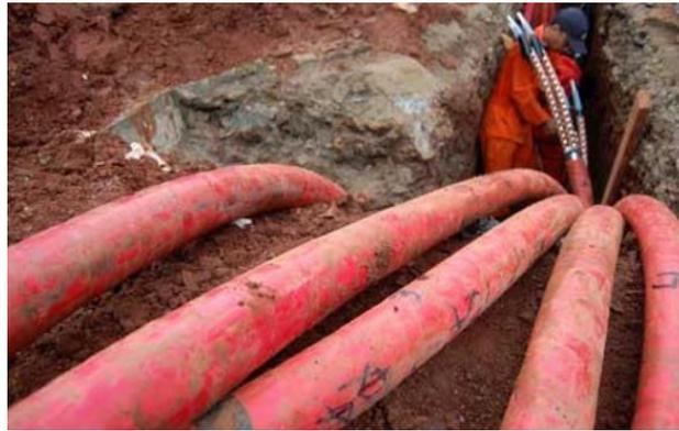
Gambar 2.12 Pemasangan Kabel Tanah (XLPE)
