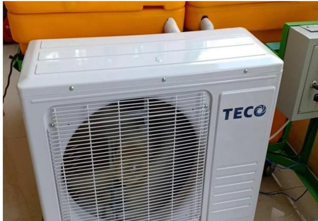
Gambar 2.3 mesin kompresor(outdoor)
