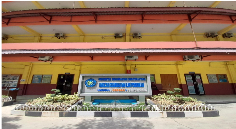
Gambar 3.1 Gedung B FKIP UMSU
