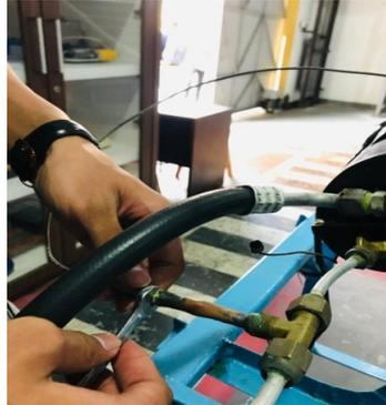
Gambar 4.16. Pemasangan sensor dari driyer ke evaporator
