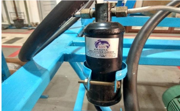
Gambar 3.11 Receiver Dryer Sebagai Penyaring
