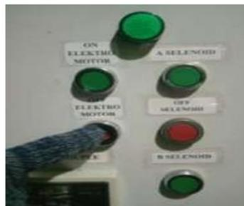
Gambar 3.34. Push button off elektro motor (Dokumen pribadi)
