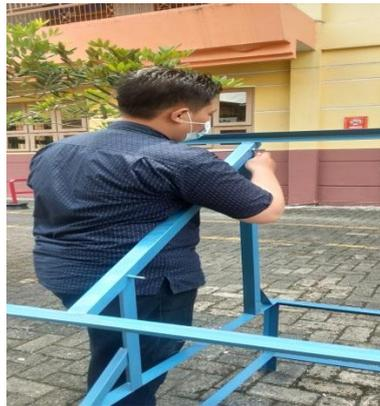
Gambar 3.18 Pemasangan Tiang Penyangga Dudukan Panel Surya
