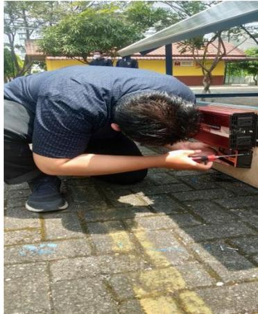
Gambar 3.20 Pemasangan *Charger Controller*
