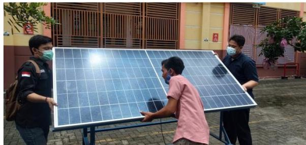
Gambar 3.19 Pemasangan Panel Surya Pada Sudut  $40^{\circ}$
