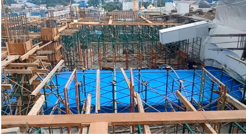
Gambar L2 : Proses pemasangan bekisting dan pembesian
