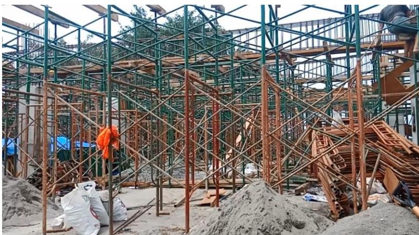
Gambar L4 : Proses pemasangan bekisting dan pembesian
