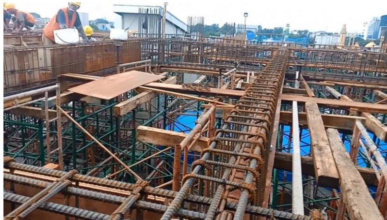
Gambar L1 : Proses pemasangan bekisting dan pembesian
