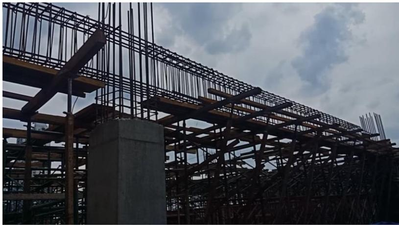
Gambar L3 : Proses pemasangan bekisting dan pembesian
