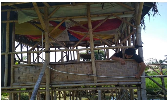
Gambar 4.5 Pemasangan Kabel BC
