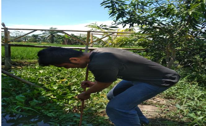
Gambar 4.6 Pemasangan Elektroda Batang
