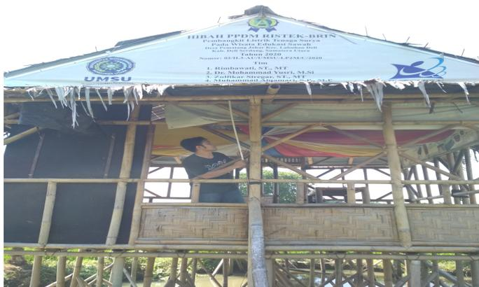
Gambar 4.4 Pemasangan Kabel BC
