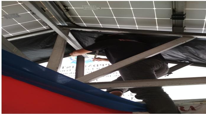
Gambar 4.3 Pemasangan Rod Arrester Jenis Splitzen
