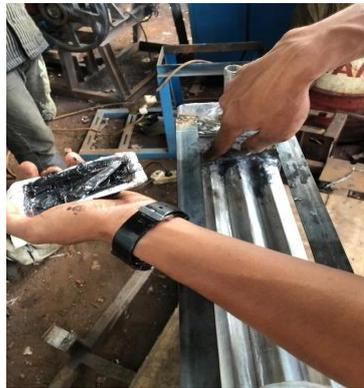
Gambar 3.25 Menambal Permukaan Saluran Pipa Panas
