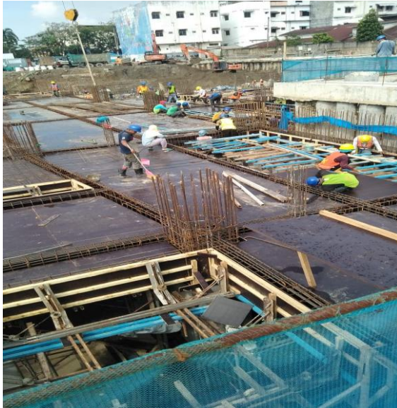
Gambar L3: Setelah Pekerjaan Bekisting
