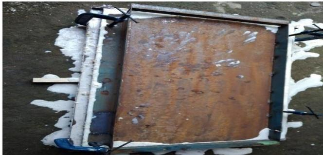
Gambar 3.29 Menutup Cetakan Menggunakan Bais C dengan 4 sudut
