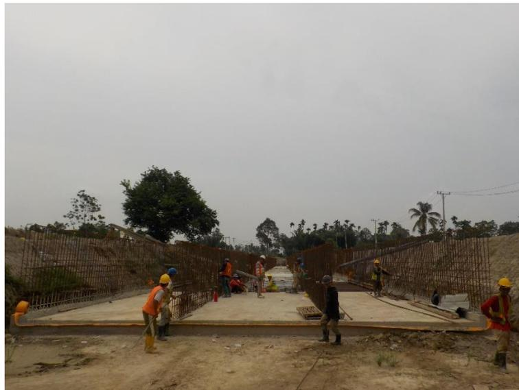
Gambar L4.2: Persiapan pengecoran lantai kantong lumpur kanan
