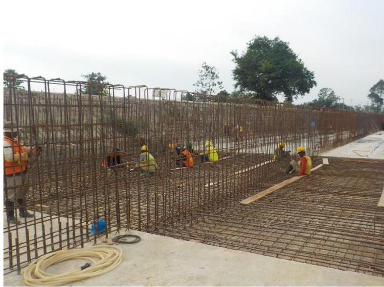
Gambar L4.1: Pekerjaan pembesian lantai dan dinding bekisting dinding samping kanan kantong lumpur kanan
