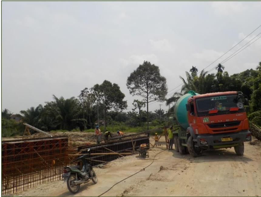
Gambar L4.5: Pengecoran dinding samping kanan kantong lumpur kanan
