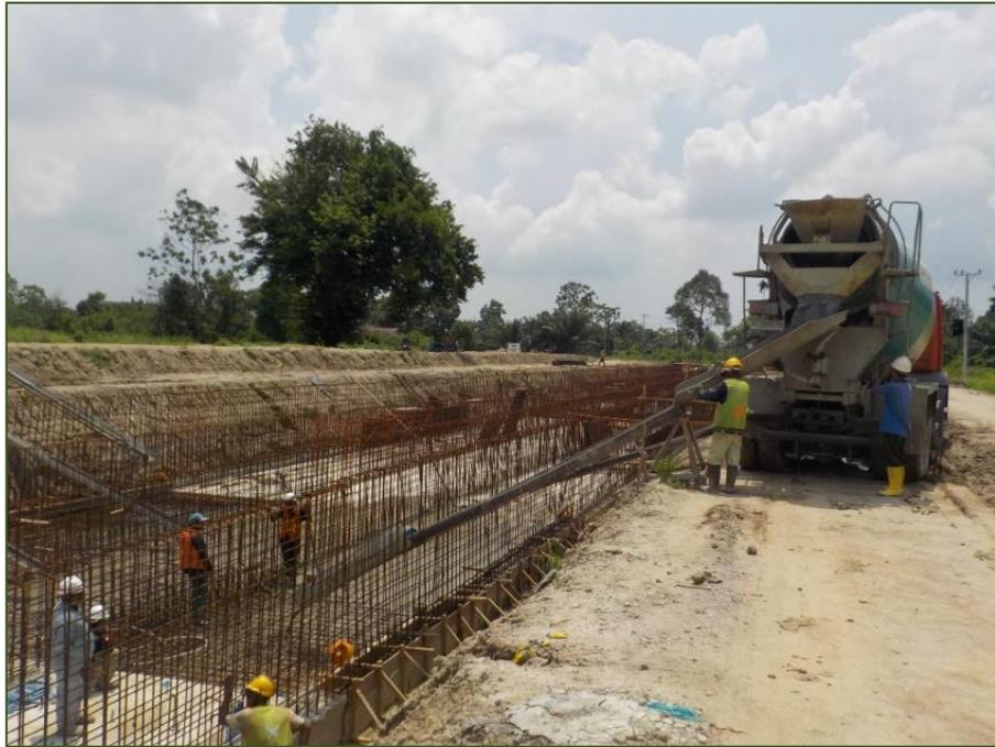
Gambar L4.3: Pengecoran lantai dan kickers kantung lumpur kanan
