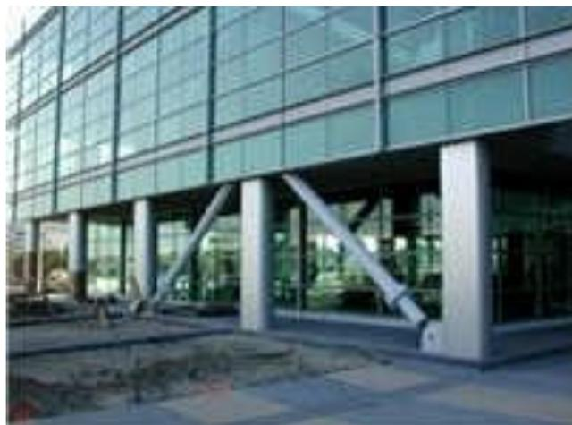
Gambar 2.15: Aplikasi penggunaan *fluid viscous damper* pada bangunan gedung.
