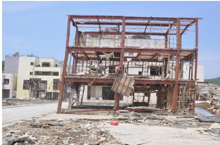
Gambar 2.7: Contoh perilaku bangunan baja selama aksi seismik.
