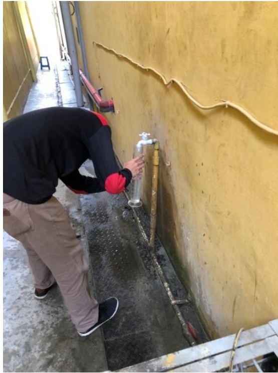
Gambar L3. Menyiapkan Air Untuk Pengerjaan Beton
