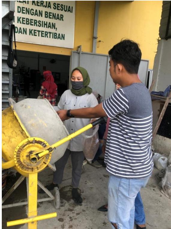
Gambar L5. Memasukkan Bahan Penyusun Beton Ke dalam Mixer
