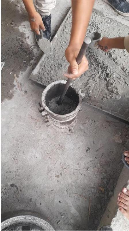
Gambar L.21: Perojokan adukan beton di cetakan.
