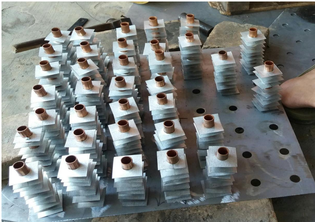
Gambar 3.28 Memasang pipa tembaga kedalam plat besi
