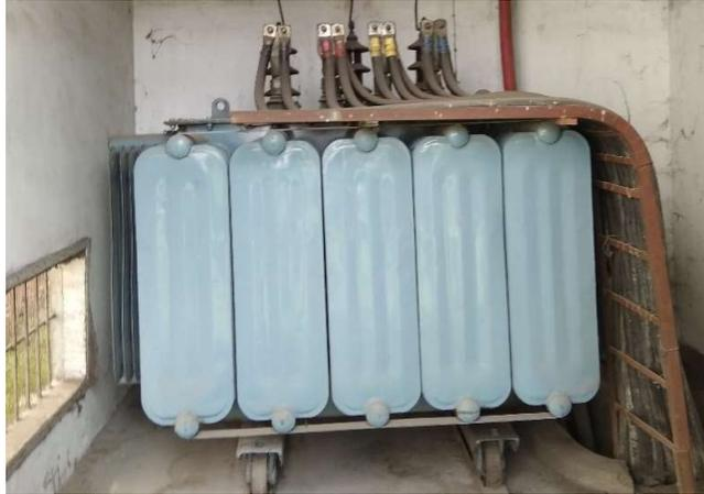
Gambar 2.10 Trafo daya 555 kVA di Pabrik Kelapa Sawit Adolina
