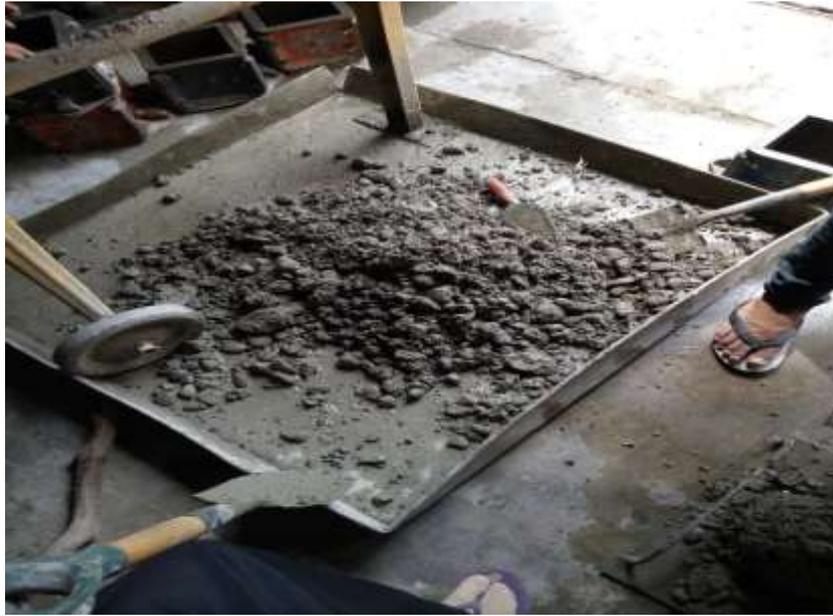
Gambar L5: Proses pencampuran agregat.
