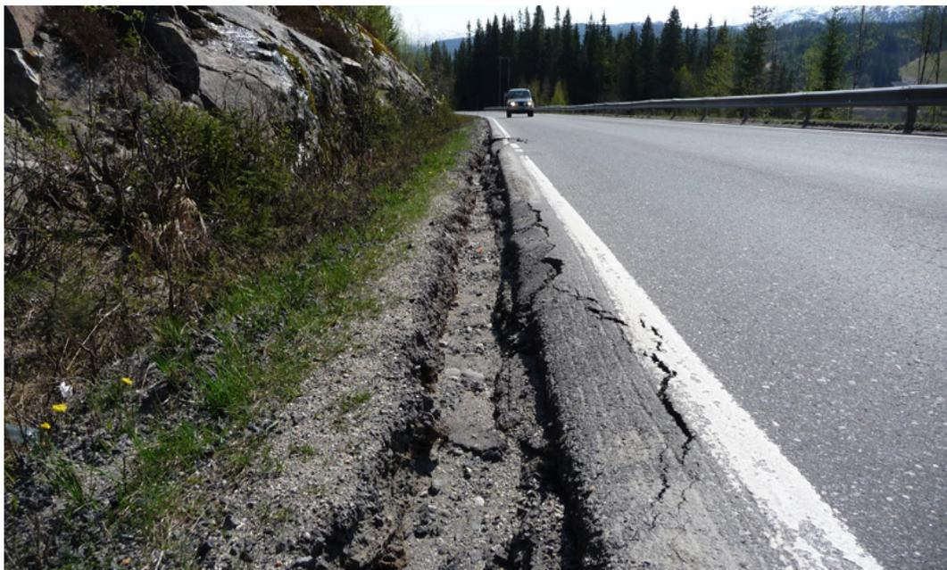
Gambar 2.7: Retak pinggir (Bina Marga, 1983).
