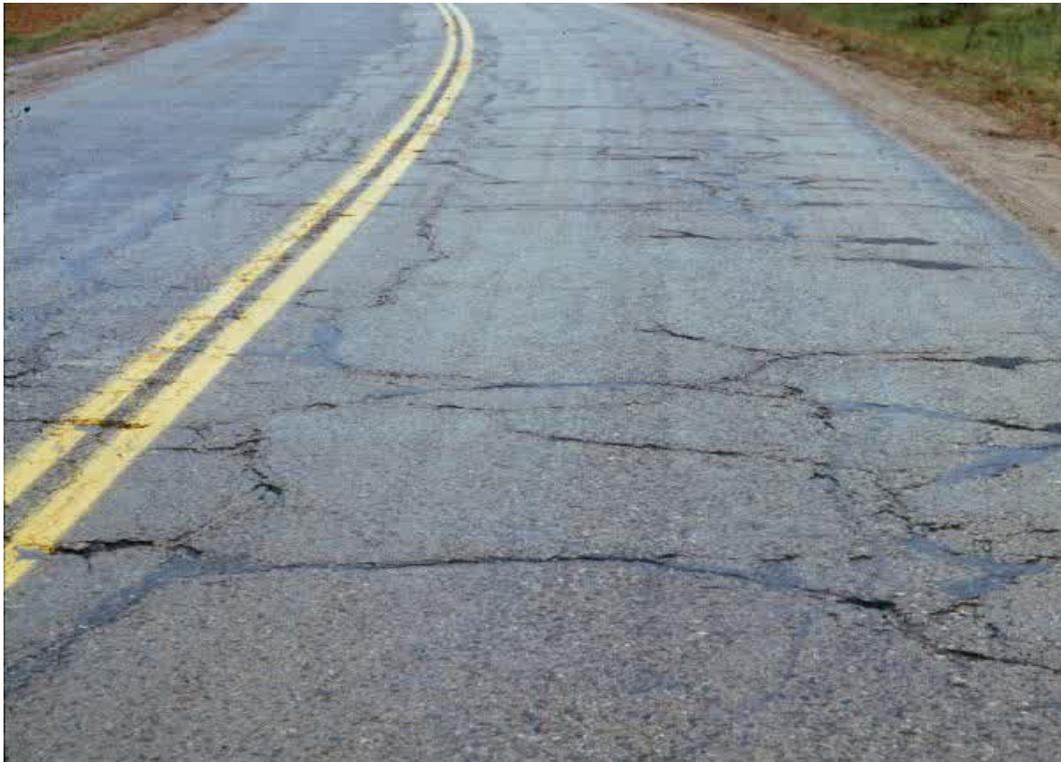
Gambar 2.4: Retak blok (Bina Marga, 1983).
