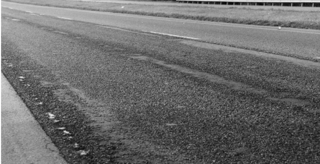
Gambar 2.15: Pelepasan butir (Bina Marga, 1983).
