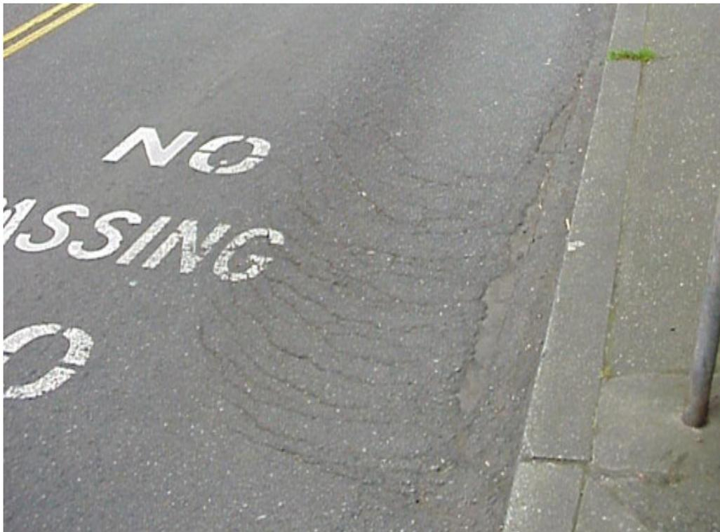
Gambar 2.14: Retak Slip (Bina Marga, 1983).
