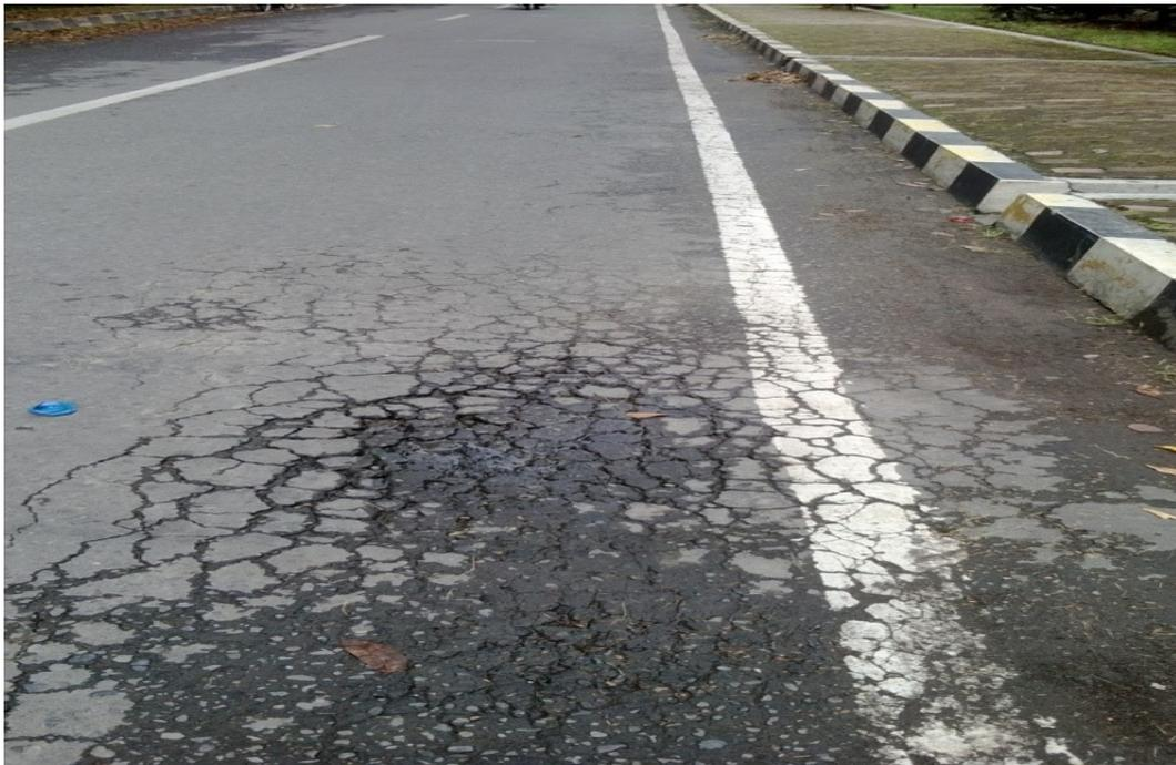
Gambar 2.2: Retak kulit buaya (Bina Marga, 1983).
