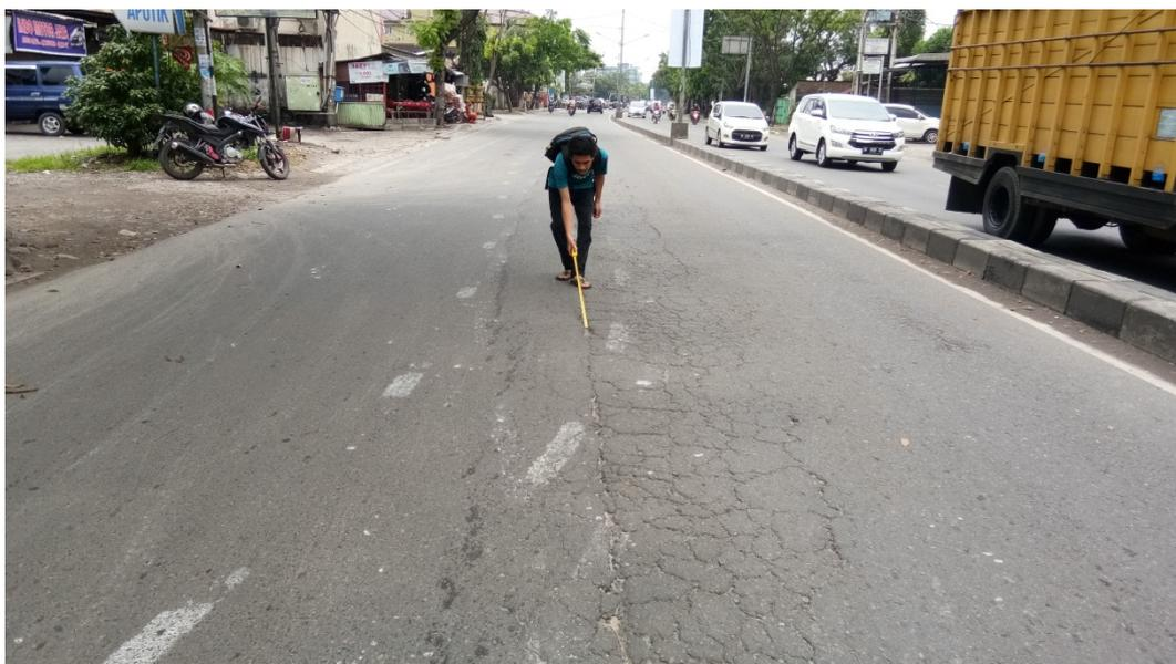
Gambar L.14: Retak blok
