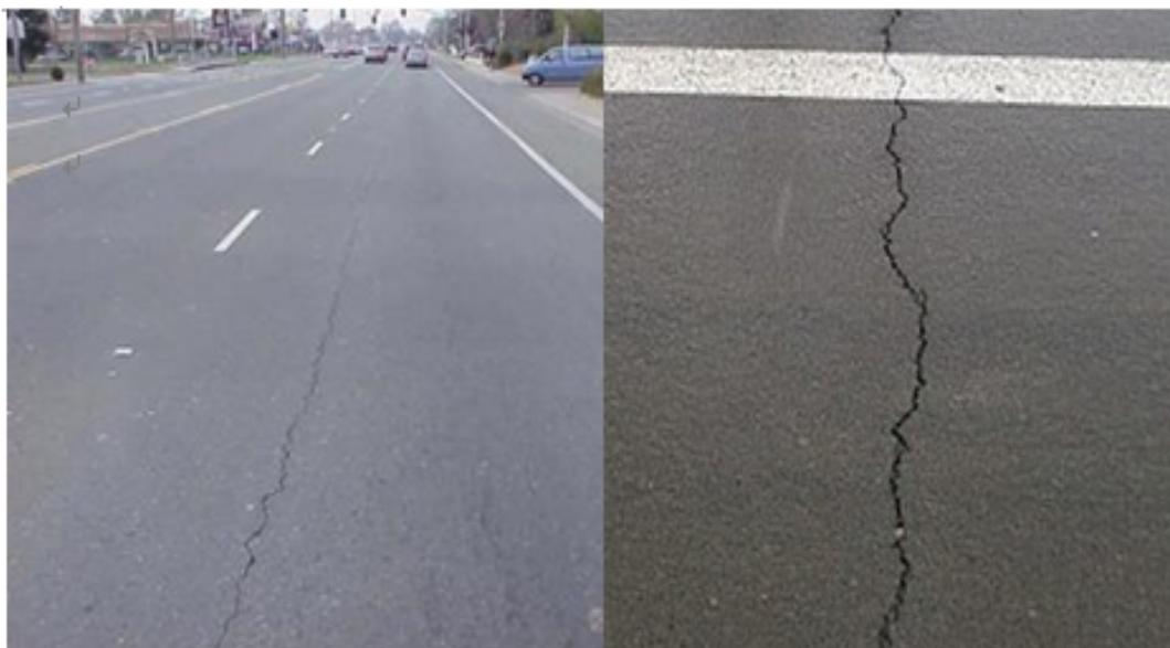
Gambar 2.9: Retak Memanjang/Melintang (Bina Marga, 1983).
